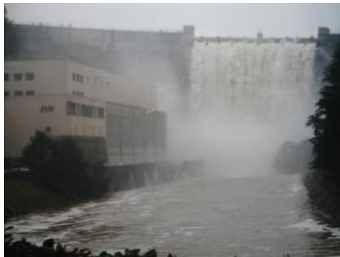
Staumauer Stausee Ottenstein
